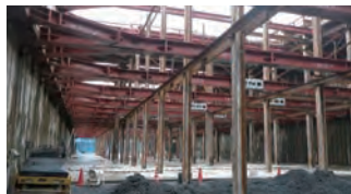
地下構造物仮設設計
