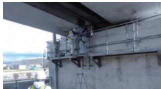
銅橋塗膜調査
