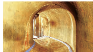
重要文化財施設補修設計
