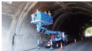
トンネル点検
