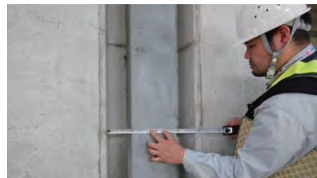
耐震補強設計対象橋の事前調査
